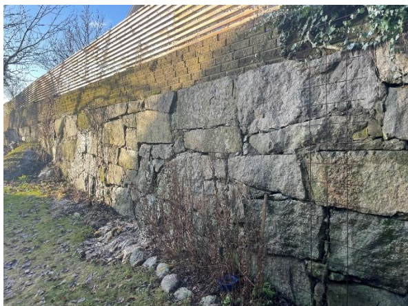
Figur 4. Kallmur i sydväst.
